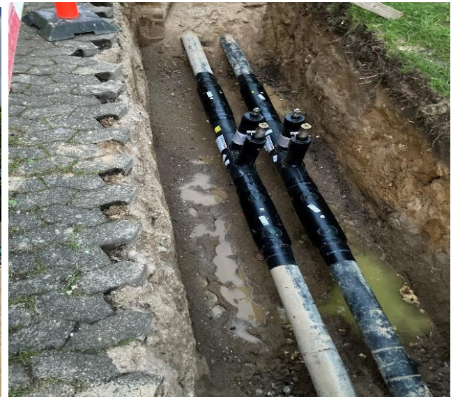
I alt 10 lejligheder under opførelse på Marienhofvej 9 B. Rørføring lagt i jorden og tilsluttet.
