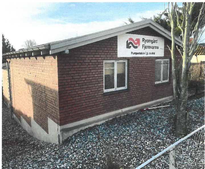
Gl. Varmecentral. Markedsgade 4. 8550 Ryomgård
