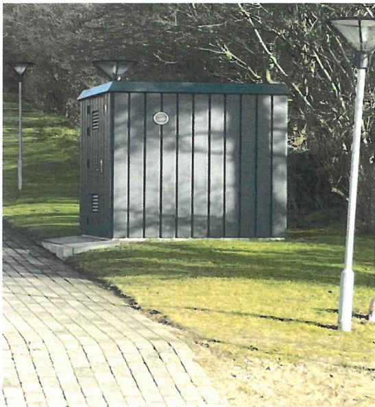
Pumpehus: Vestergade 114A 8550 Ryomgård
