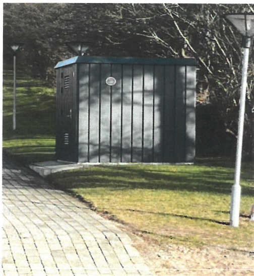
Pumpehus: Vestergade 114A
